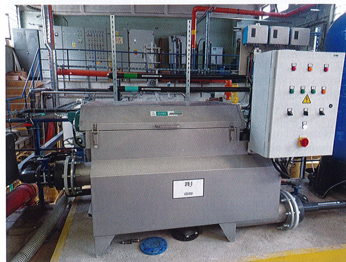
Obr. 4. Realizace – mikrosítový bubnový filtr 10 µm
