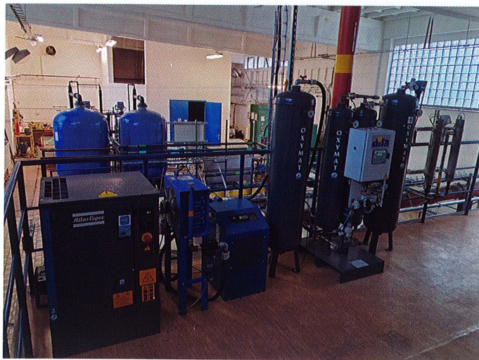
Obr. 5. Realizace – část jednotky ozonizace, v pozadí GAU filtry
